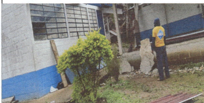
Foto 3: arrancando balcones para la nueva instalación
