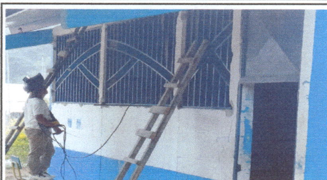
Foto 2: Los trabajadores están colocando balcones
