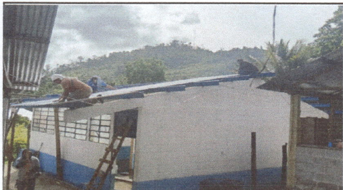
Foto 1: Instalando la cubierta de lámina por los trabajadores especializados en el área.
