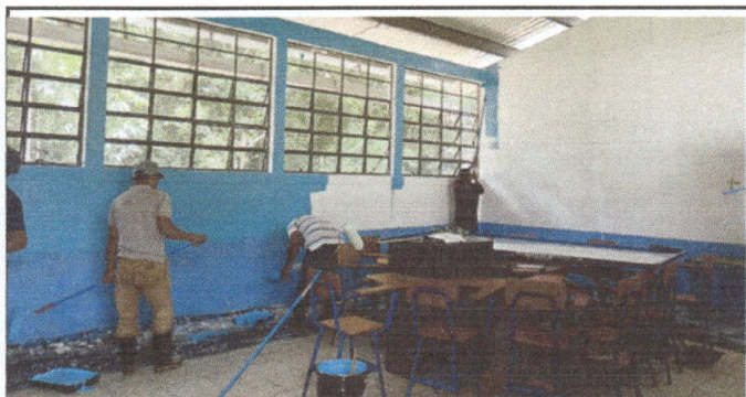
Foto 5: padres de familia pintando paredes, interiores y exteriores.
